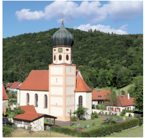
Am Martinusweg liegt die Kirche St. Gallus in Bichshausen. Foto: Andreas Steidel
